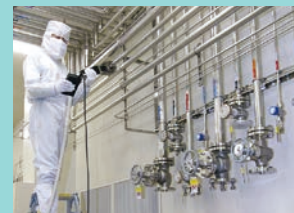
高純度ガス供給配管工事
